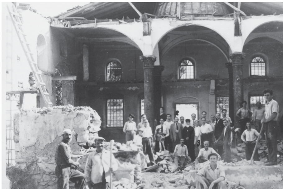
Από το έργο ανέγερσης της κατεστραμμένης Συναγωγής Βόλου μετά την απελευθέρωση.
