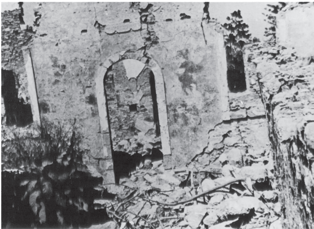
Ερειπωμένη συναγωγή στη Ζάκυνθο μετά τους σεισμούς του 1953 32
